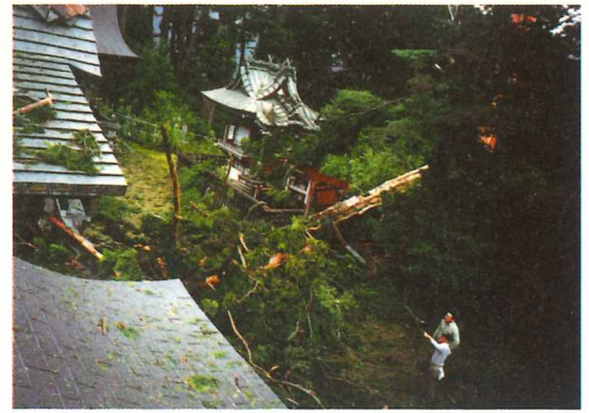
平成8年9月22日の被害
