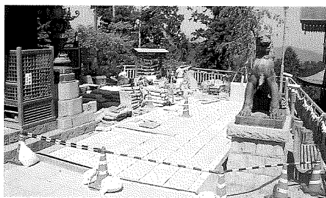
拝殿前敷石工事
