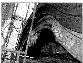
古い漆を綺麗に洗い落とす作業から始められます。
