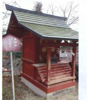
東照社 土台部分腐朽修理工事
