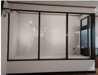
照明工事によりベース照明・スポットライトを設置。
